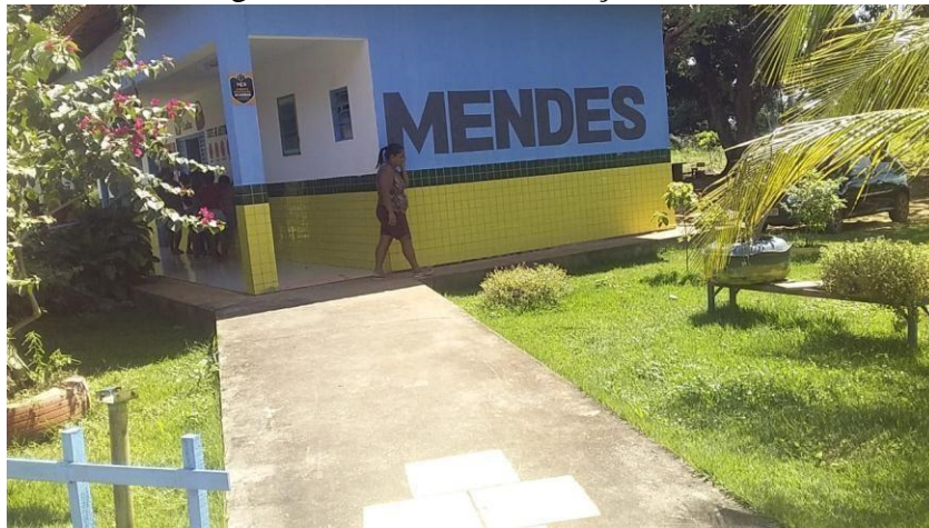
Figura 10 - Bloco dos Serviços Gerais
