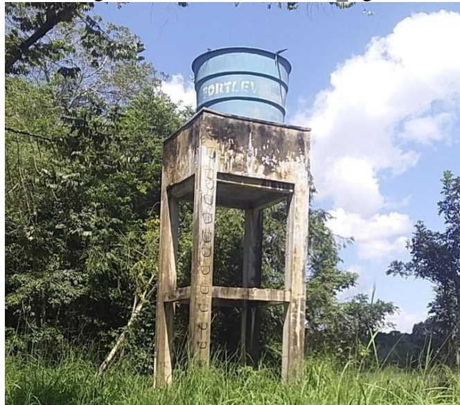
Figura 3- Estrutura da caixa d'água
