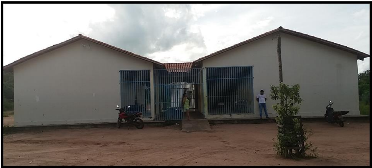
Figura 1 - Atual prédio escolar (2019).
