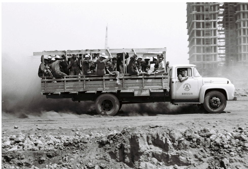
Figura 08: Caminhão de operários próximo ao futuro prédio do Congresso Nacional.
