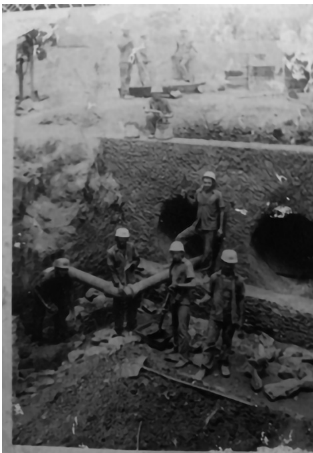
Figura 4: Onildo e seus colegas de trabalho na construção de bueiros, 1969
