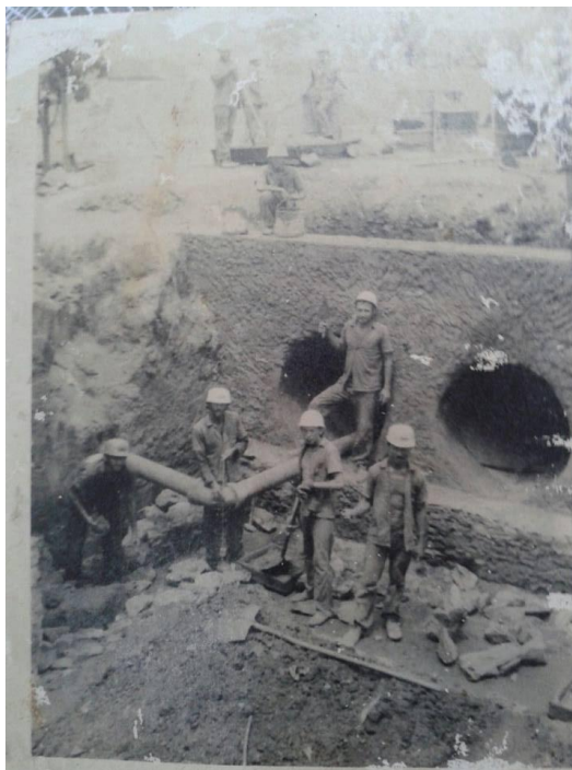
Figura 13: Onildo Pereira de Sousa e colegas na construção de bueiros, 1970
