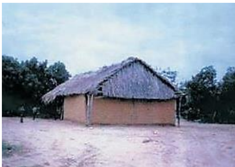
Figura 31 - Estrutura das construções no povoado Canela
