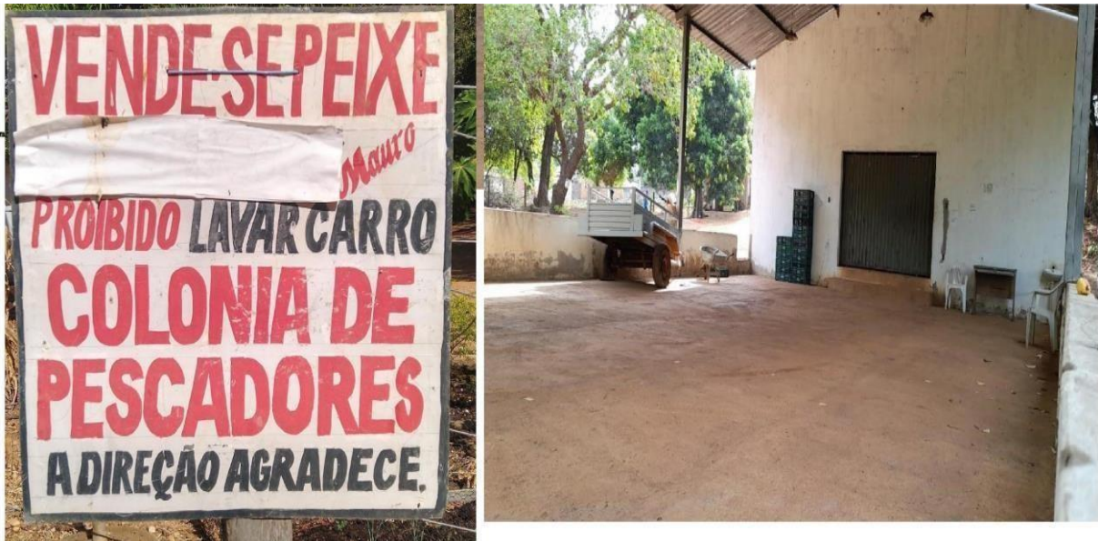
Figura 3 Galpão da Colônia de Pescadores de Porto Real Z-04
