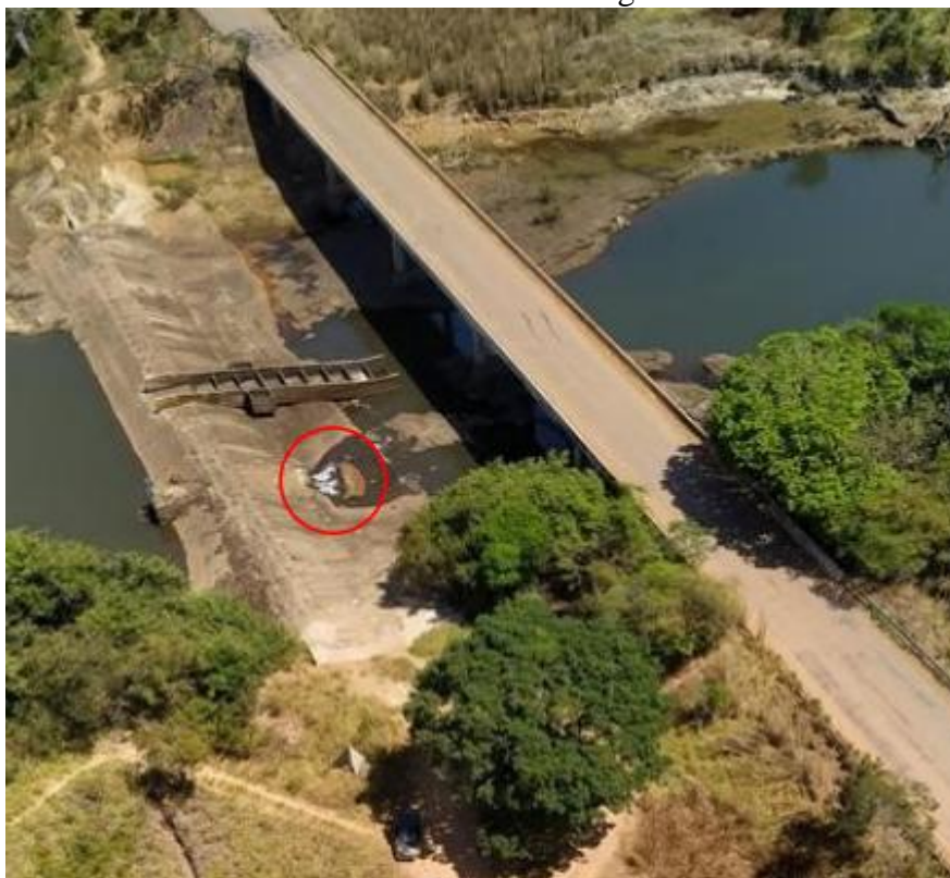
Figura 17 – Vista do barramento Eixo Ponte no Rio Urubu. Foto do Ministério Público do Estado do Tocantins de 16 ago. 2021
