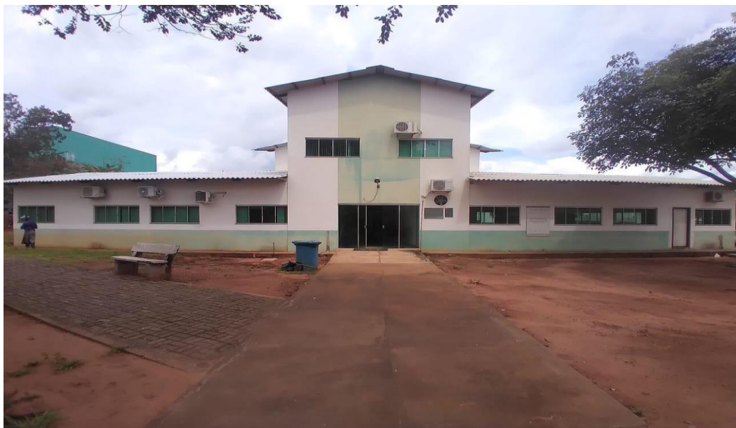
Figura 13 – Visão frontal do prédio onde funciona o restaurante universitário no Centro de Ciências Integradas, somente do lado direito
