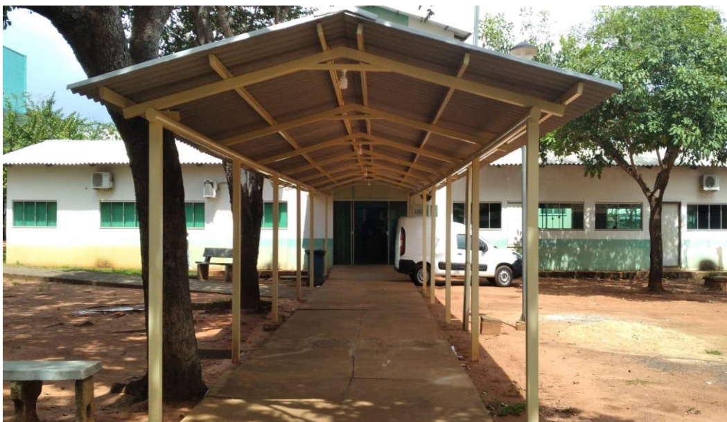
Figura 14 – Visão frontal do restaurante após construção da cobertura na passarela
