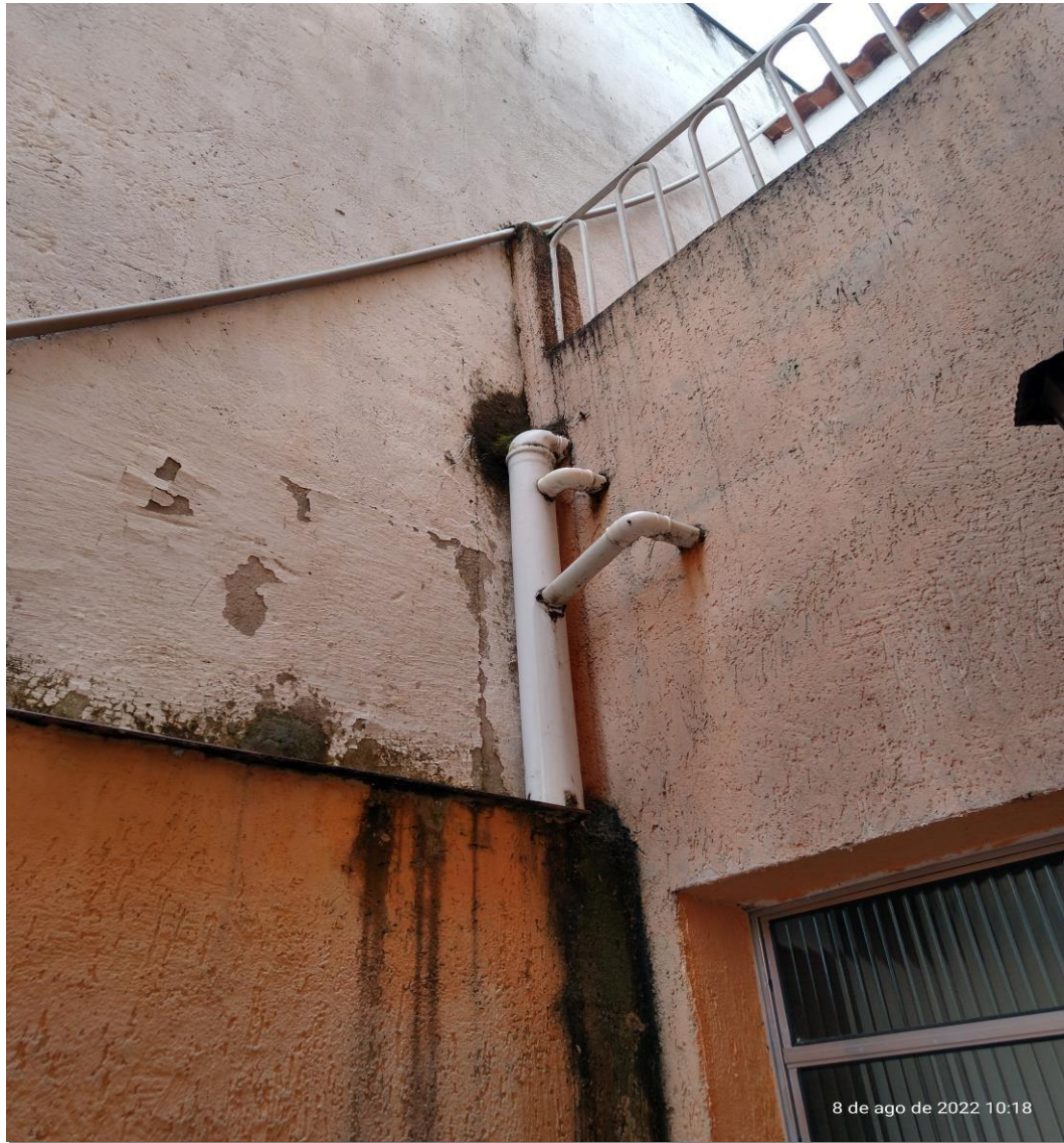
Figura 3: Tubulação que coleta água do banheiro do piso superior
