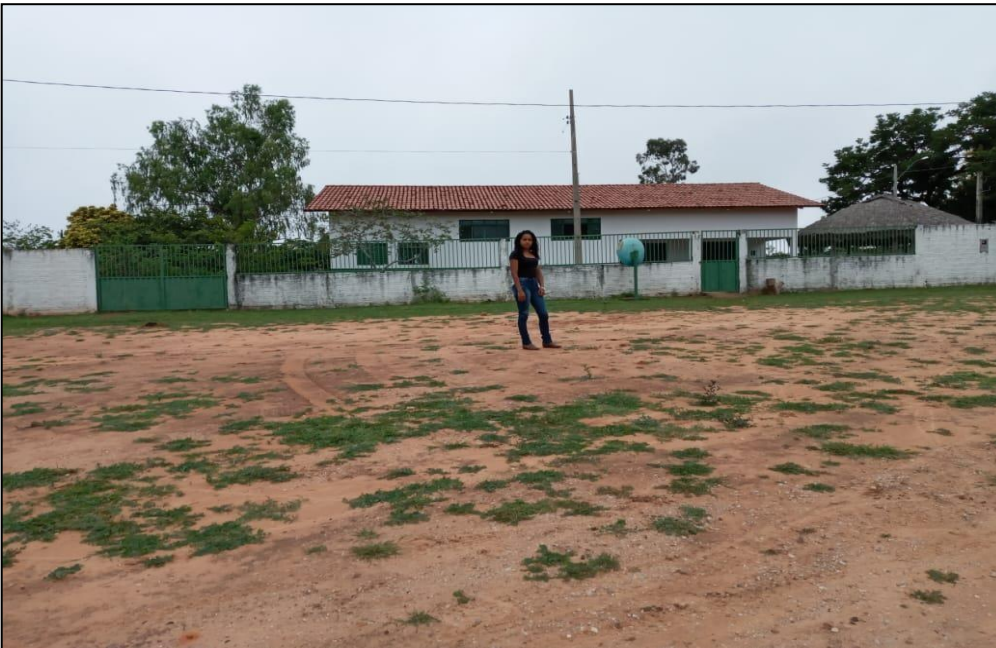
Figura 2- Estrutura Física externa da Escola Municipal Miguel Rodrigues de Sousa.
