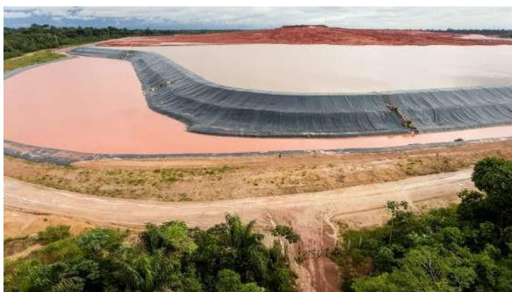
Figura 3- Barragens de rejeitos de Bauxita da Alunorte
