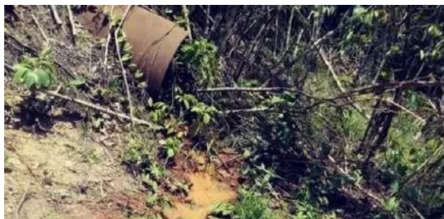
Figura 4 - Duto clandestino encontrado na região da Hydro
