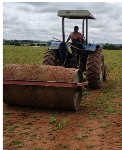
Figura 13 - Rolo compactador para acerto de terreno
