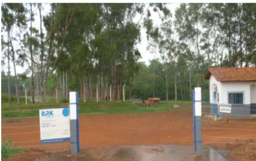
Figura 16 – Estação Elevatória de Esgoto Vila Couto, Araguaína – TO (Entrada).
