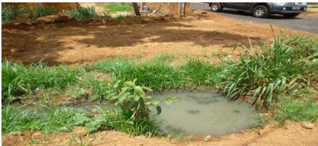
Figura 20 – Esgoto a céu aberto próximo a ETE Neblina
