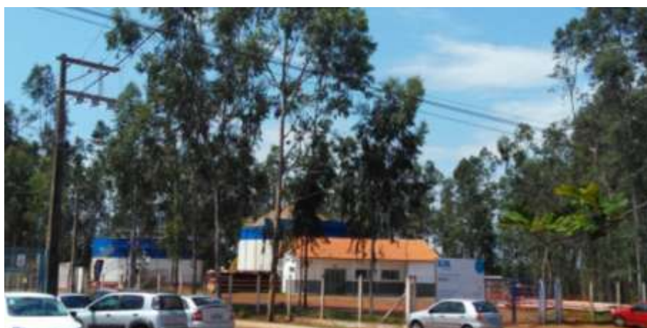
Figura 15 – Estação de Tratamento de Esgoto Neblina, Araguaína – TO.
