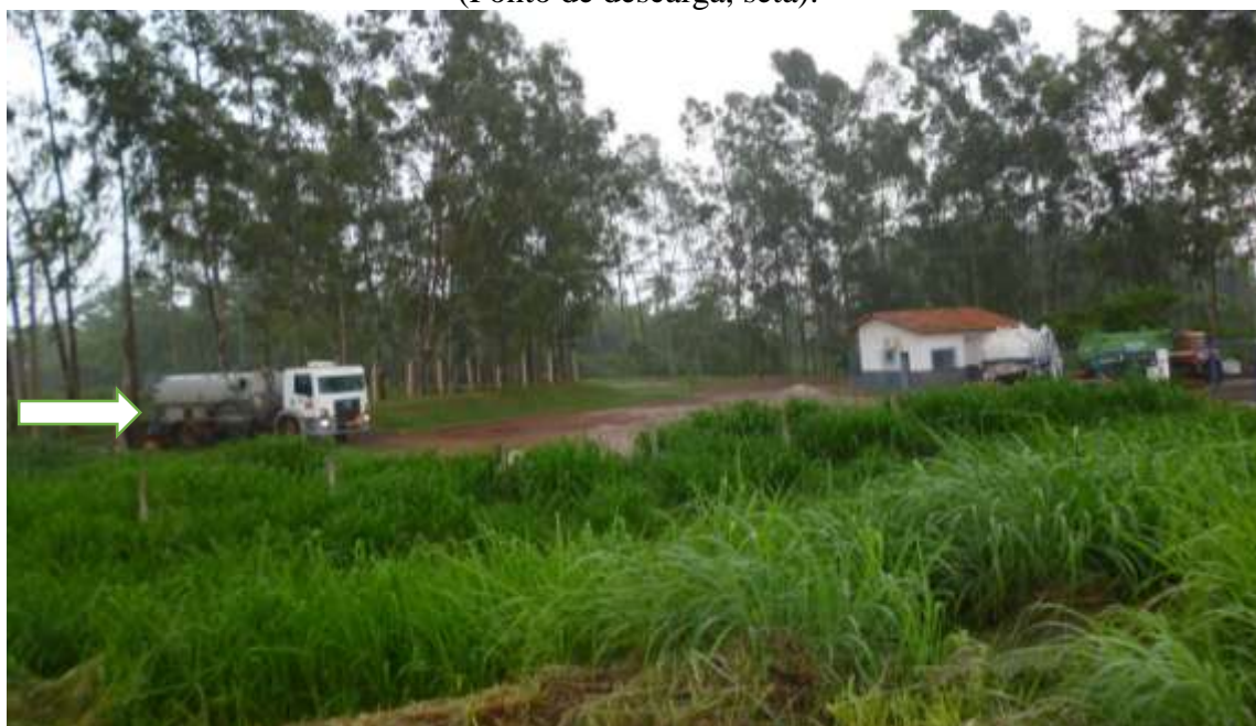
Figura 18 – Despejos de esgotos pelos caminhões limpa fossa na EEE Vila Couto (Ponto de descarga, seta).
