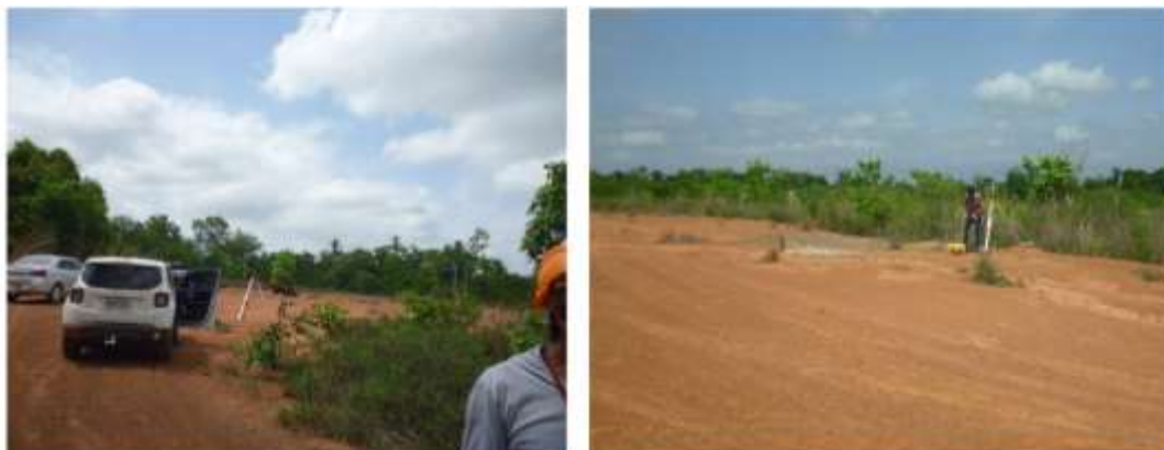
Figura 24 – Local de construção da ETE Lontra no Setor Barra da Grota.
