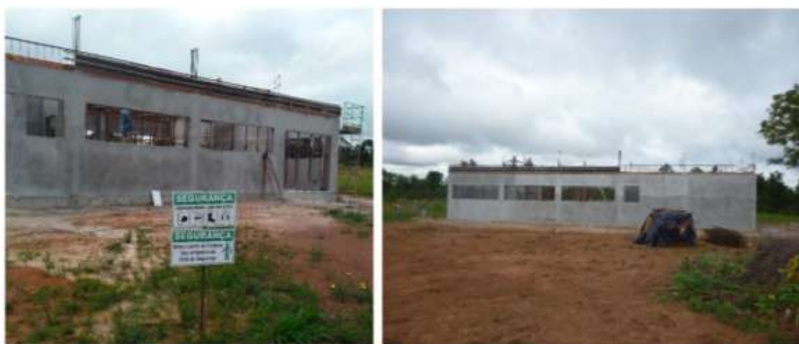
Figura 26 – Construção do prédio de apoio na área da ETE Lontra (setor Barra da Grota).
