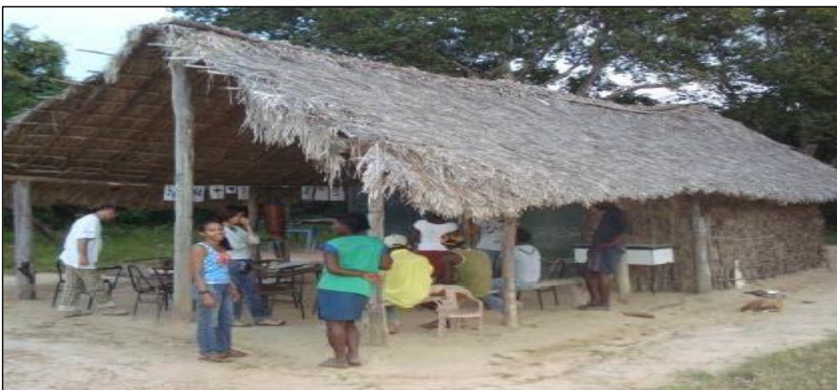
Foto 3 - Escola Municipal Polo Matas antes da construção
