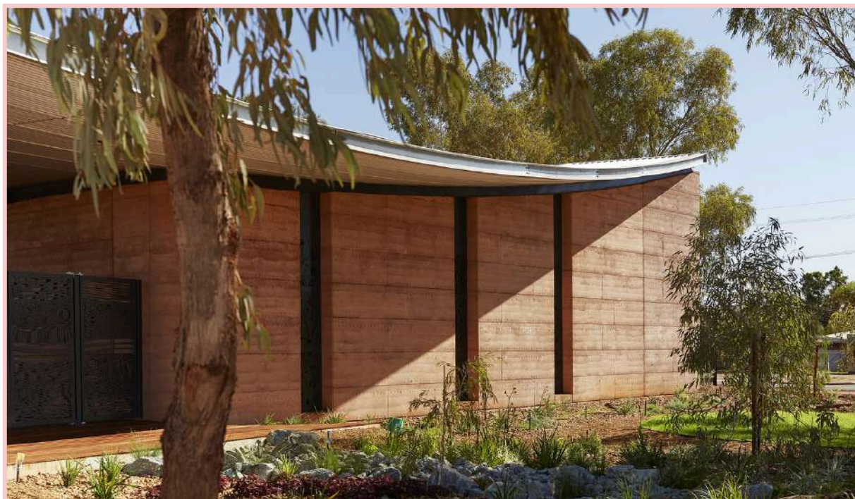
Figura 13 – Detalhe da fachada do Centro de Saúde PAMS - Uso da taipa em sua volumetria.
