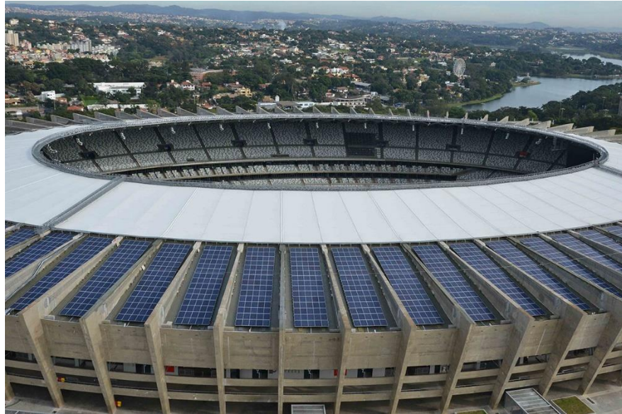
Figura 41: Usina solar no Mineirão em Belo Horizonte
