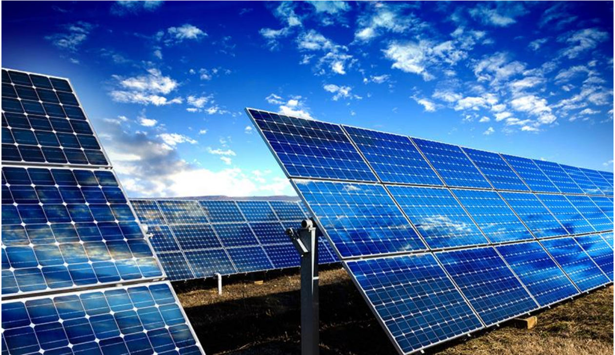
Figura 15: Painel Solar Fotovoltaico
