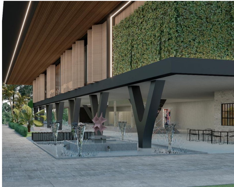
Figura 52 – Área de Convivência Externa (Sol Coworking)
