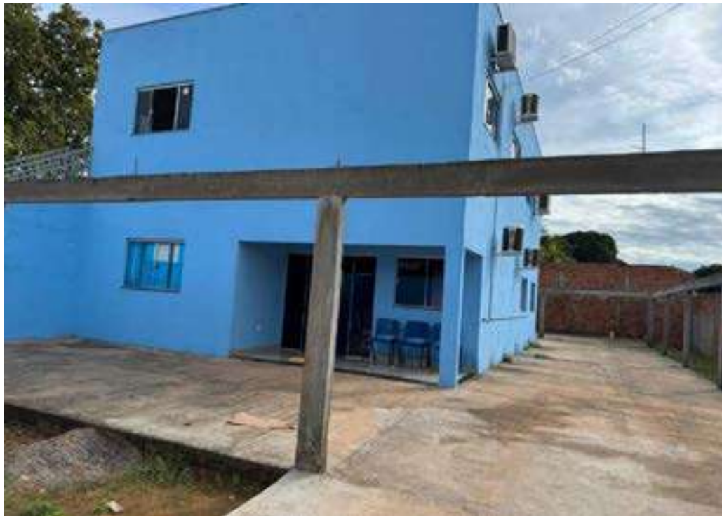
Figura 17 - Fachada do prédio onde funciona a Secretaria Municipal de Educação de Ipueira
