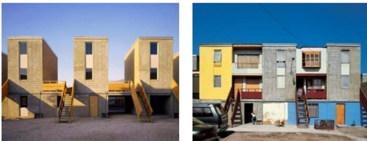
Figura 5 - Projeto Quinta Monroy, da Elemental executado no Chile
