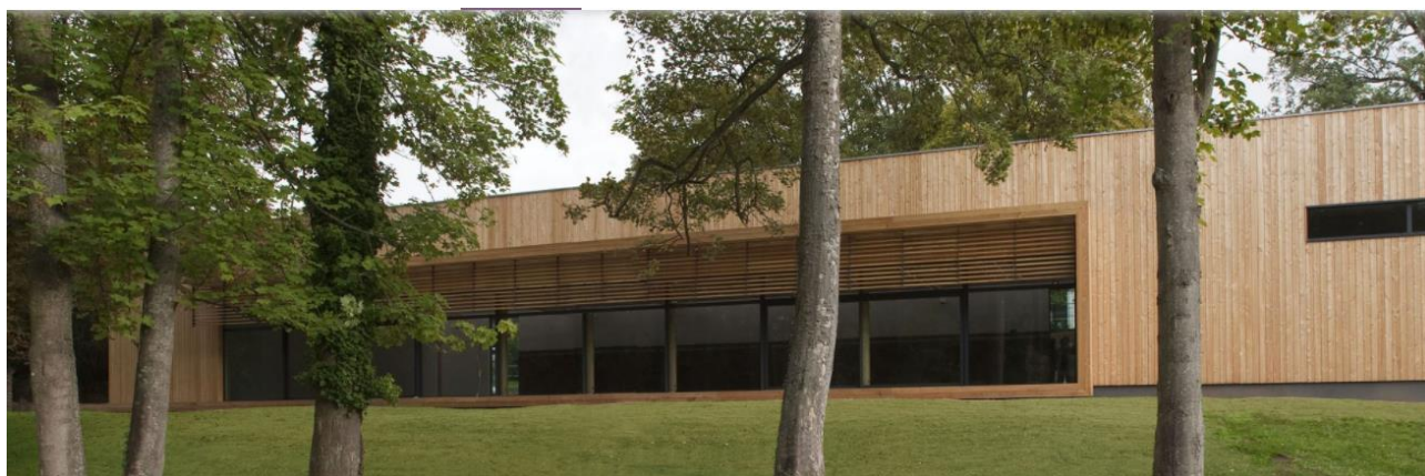
Figura 11 -Fachada revestida em madeira se integra com a paisagem do entorno.
