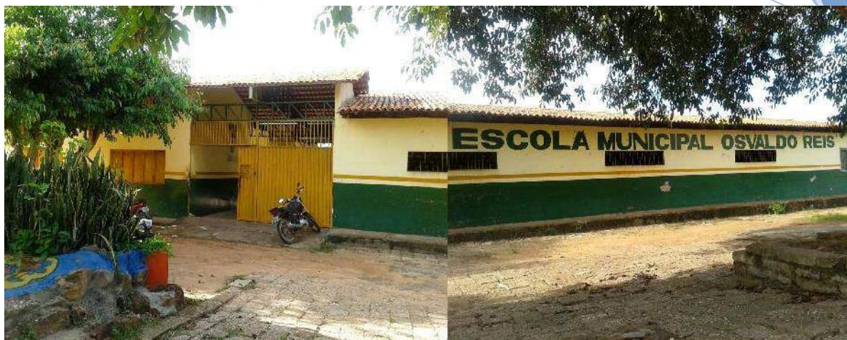
Figura 02: Fachada da Escola Municipal Osvaldo Reis Fonte: Anexos da escola
