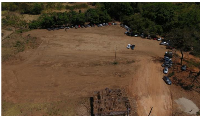
Figura 65 - Foto tirada por drone da construção do novo estacionamento mais distante do rio.
