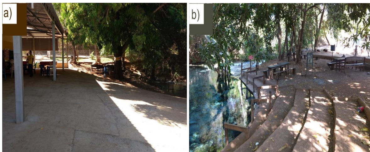
Figura 60 - a –Áreas concretadas, b – Construção de escadarias nas margens do rio Azuis.
