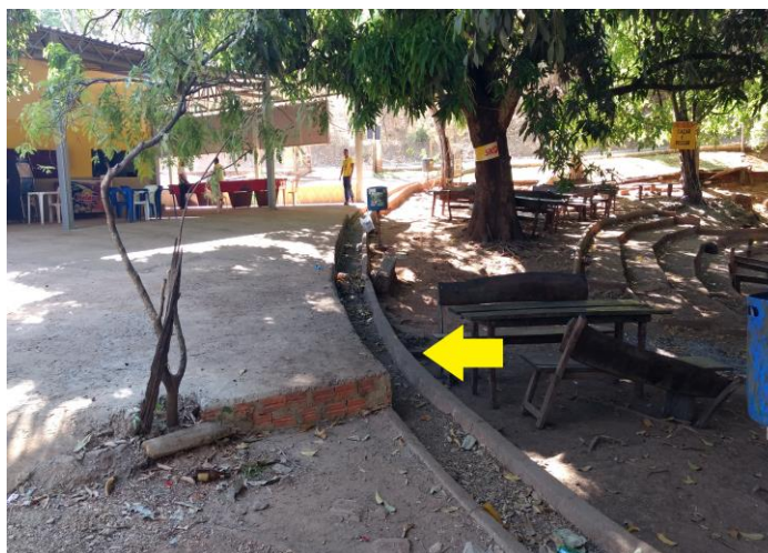
Figura 61 - Presença de canaleta para mitigação dos impactos gerados pela pavimentação da estrada.
