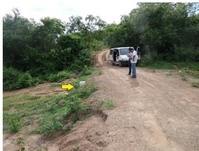
Figura 43 - Ponto 4. Presença de manilha para passagem de água.
