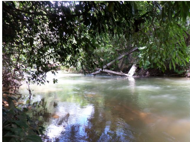
Figura 46 - Ponto 5.2 – Ponte quebrada nas proximidades do rio Azuis.
