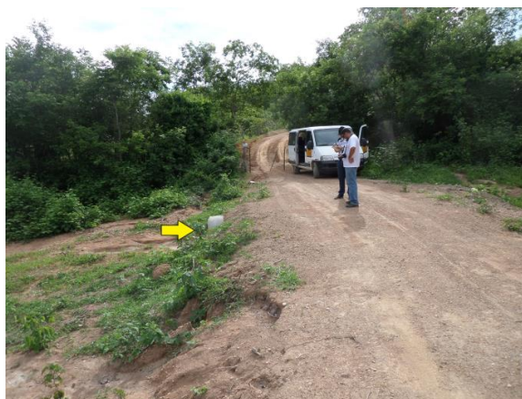
Figura 33 - Presença de manilhas para a passagem de água.
