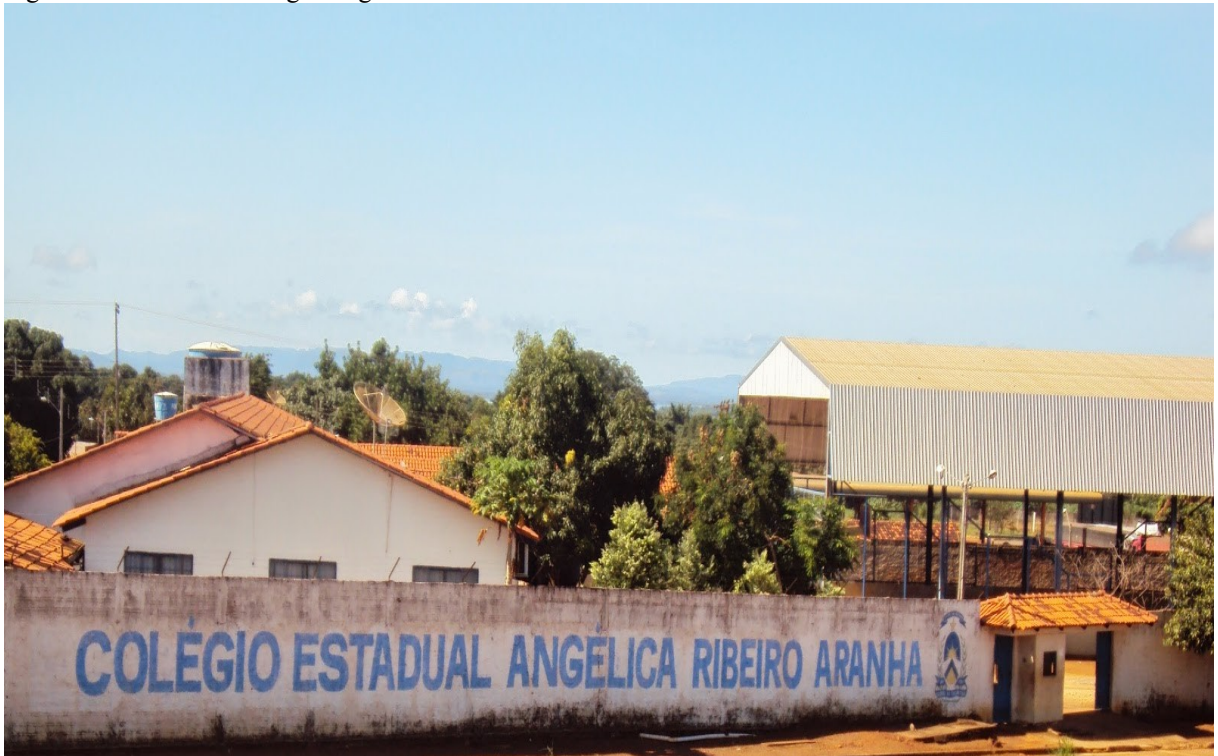
Figura 4: Fachada do Colégio Angélica Ribeiro Aranha.
