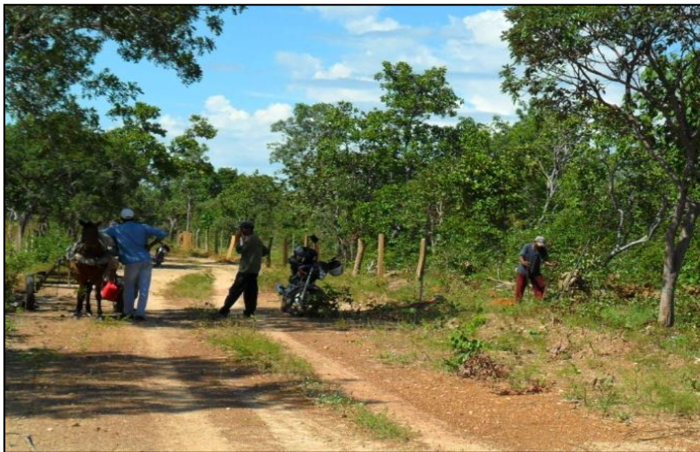
Figura 3 - Construção da cerca de um sítio na Comunidade Angical
