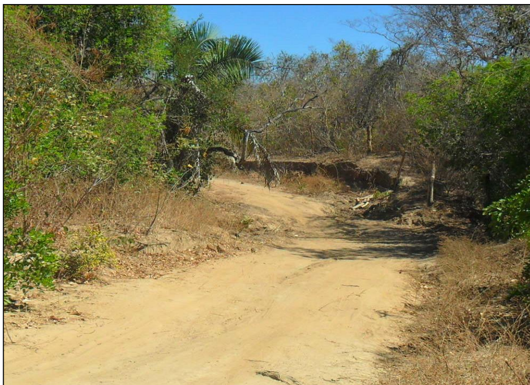
Figura 14 - Local de passagem sobre o Córrego Palmeira
