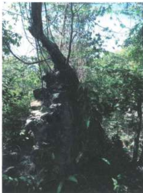
Figura 10 – Árvore que cresceu justaposta à parede da ruína da Igreja. Fonte: Acervo IPHAN-TO
