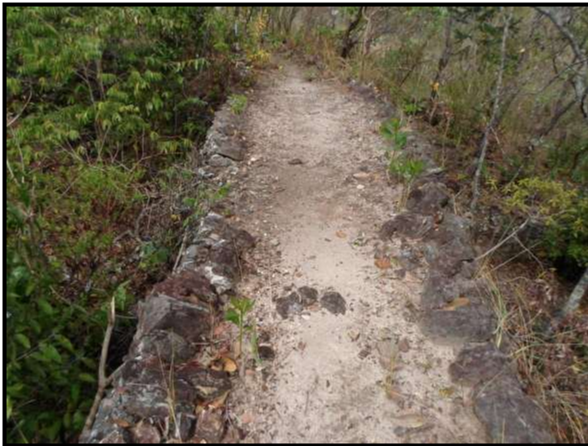
Figura 25: Ponte de pedra
