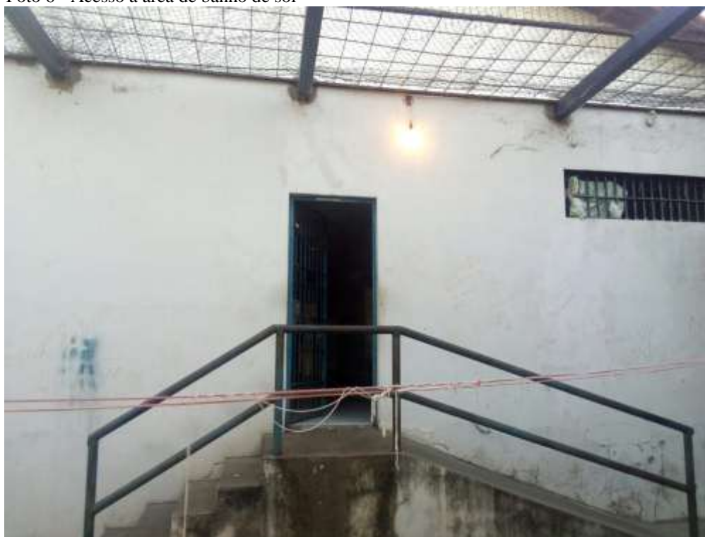
Foto 6 - Acesso a área de banho de sol
