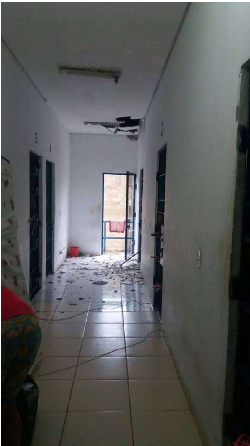
Foto 10 - Corredor de acesso às celas
