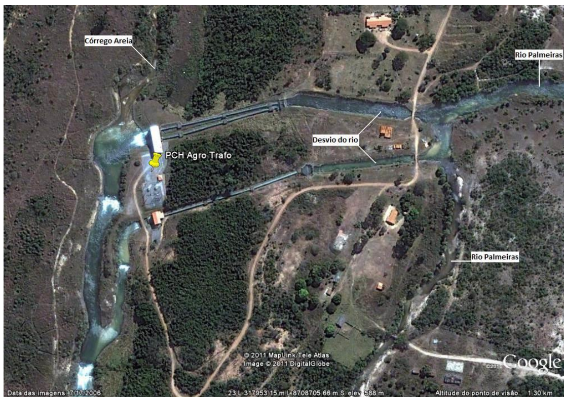
Imagem 3 - PCH Agro Trafo (Fonte: Imagem Google Earth. Acesso em: 10, jul. 2011. Modificado por: Renan Gil, 2011).
