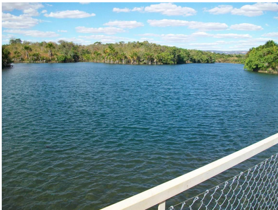
Fotografia 2 - Reservatório da CGH Ponte Alta (Foto: Enel Green Power, 2011).
