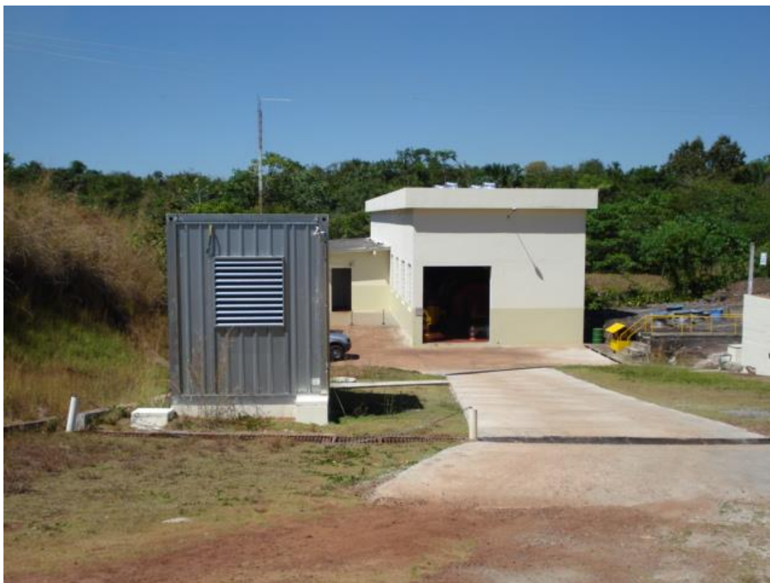
Fotografia 15 - PCH lajes, casa de força (Foto: Enel Green Power, 2011).
