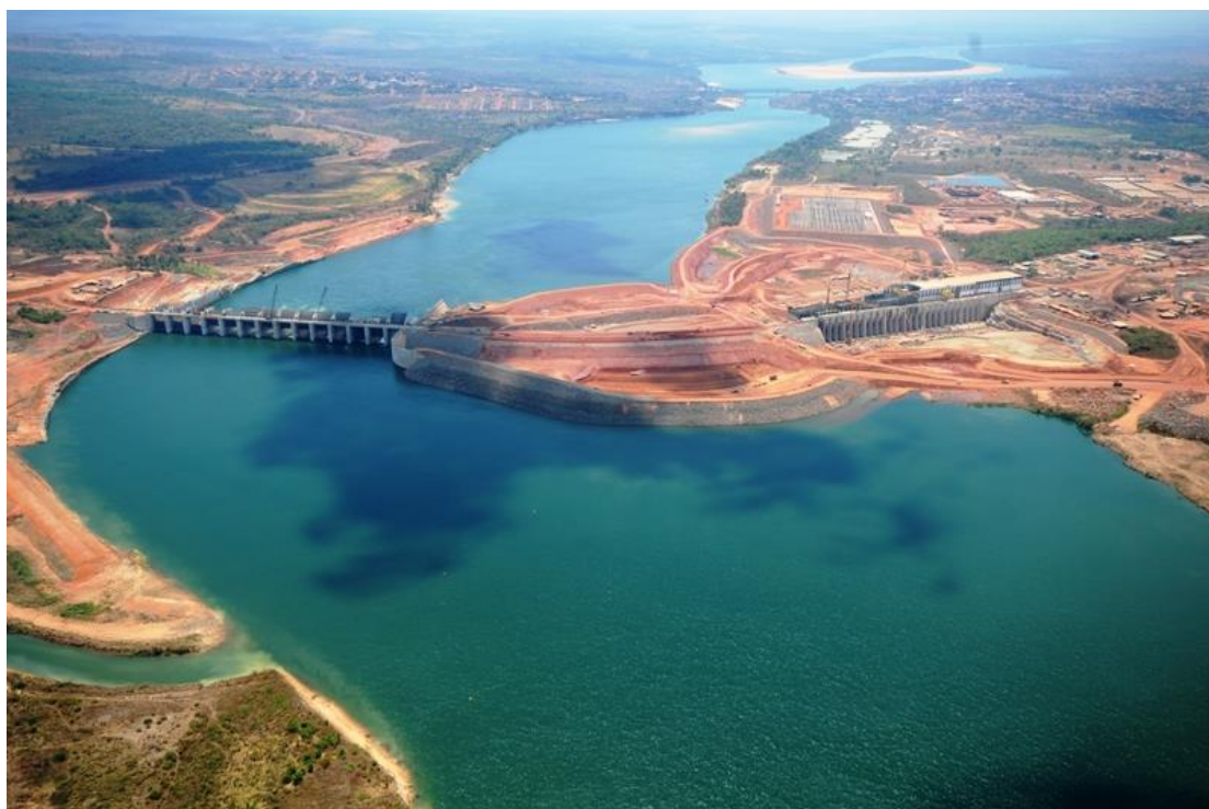
Fotografia 23 - UHE Estreito implantada com eixo do barramento nos municípios de Aguiarnópolis/TO e Estreito/MA. (Fonte - Disponível em: < http://www.folhadobico.com.br >. Acesso em: 28, out. 2011).
