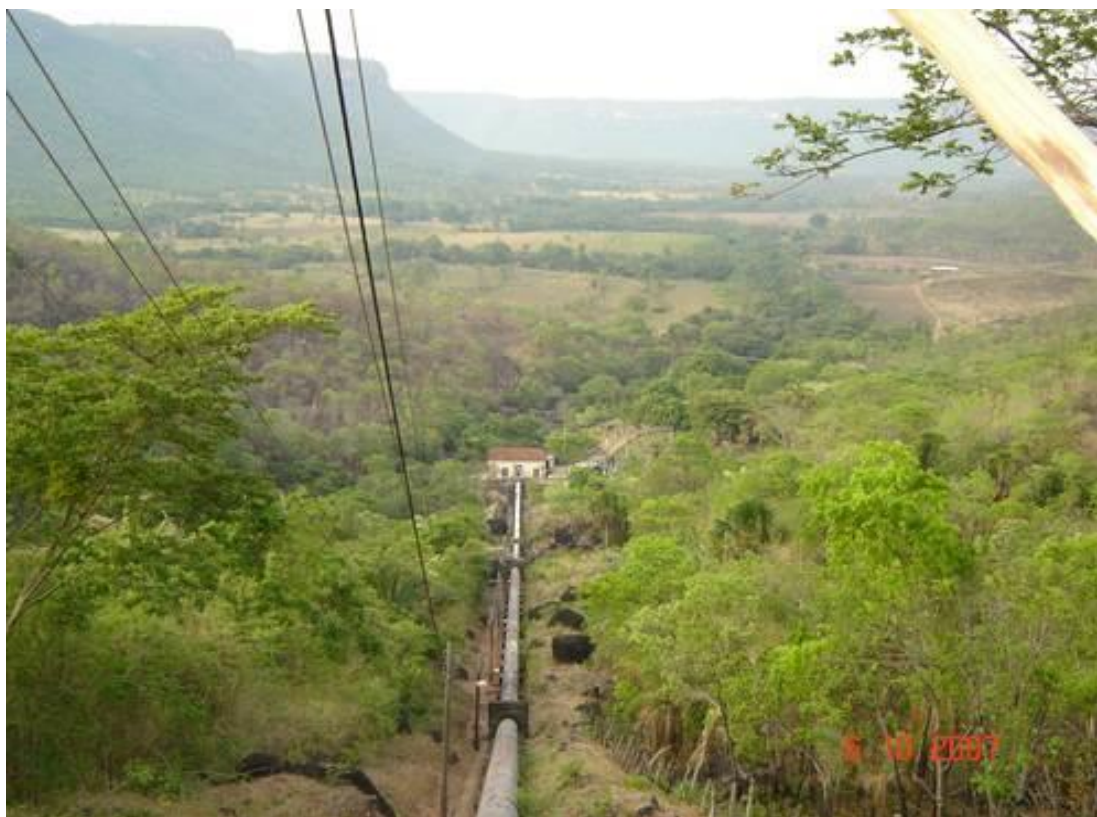
Fotografia 13 - PCH lajeado, imagem do conduito forçado da água da PCH Lajeado (Fonte: Disponível em: Google Earth. Acesso em: 29, set. 2011).
