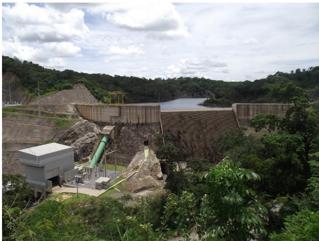
Fotografia 4 - PCH Água Limpa, reservatório e do vertedouro (Foto: Renan Gil, 2012).
