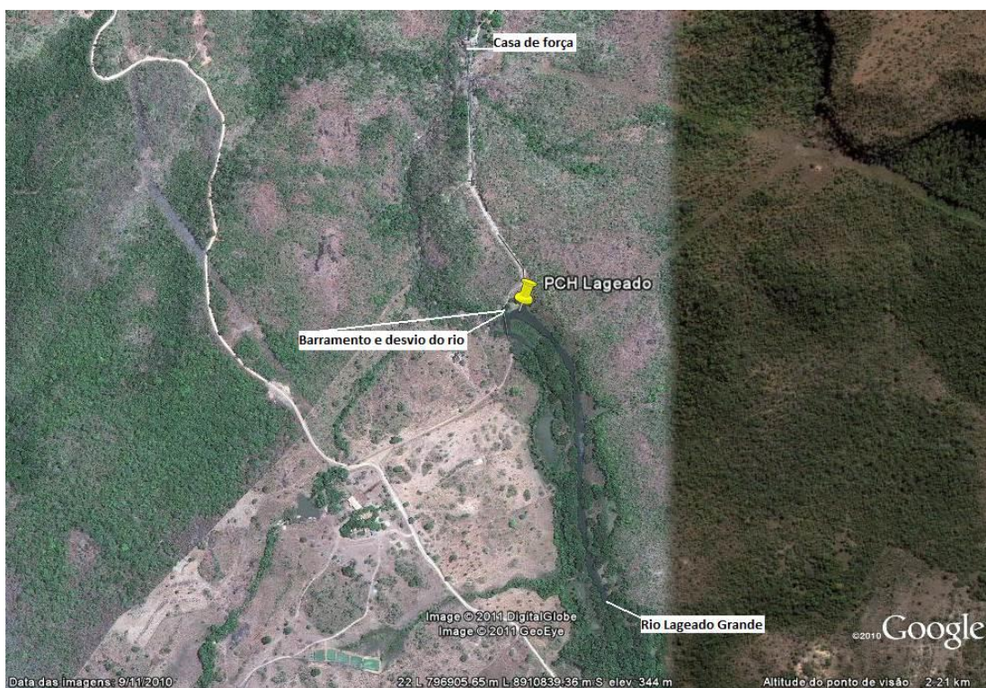
Imagem 13 - PCH lajeado, imagem do barramento e desvio do rio da PCH Lajeado (Fonte: Imagem Google Earth. Acesso em: 10, jul. 2011. Modificado por: Renan Gil, 2011).
