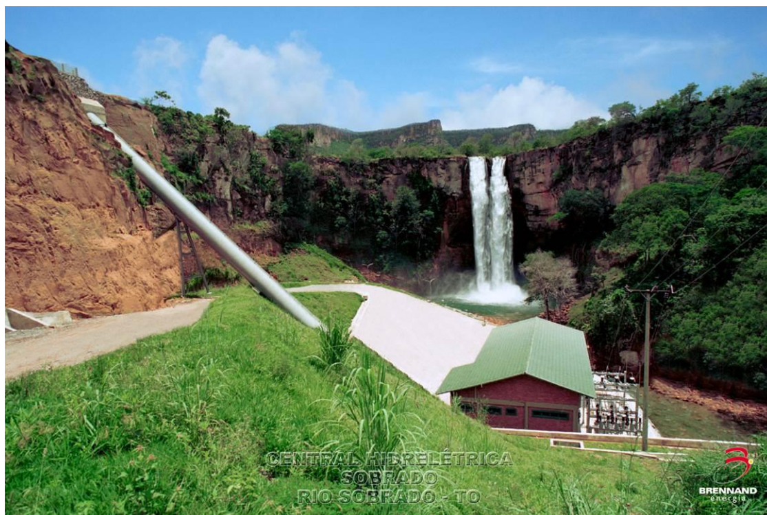
Fotografia 22 - PCH Sobrado, conduto forçado e casa de força da PCH (Fonte - Disponível em: < http://www.brennandenergia.com.br >. Acesso em: 10, out. 2011).
