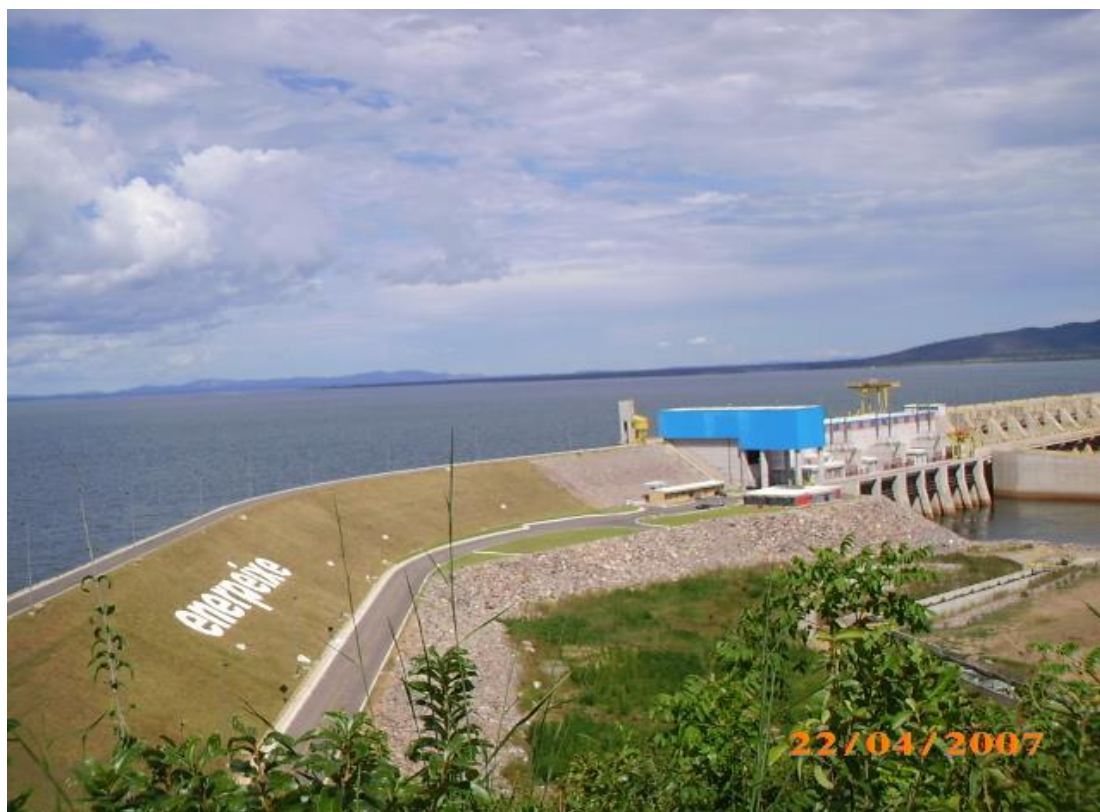
Fotografia 26 - UHE Peixe Angical, barramento (Fonte - Disponível em: Google Earth. Acesso em: 29, set. 2011).
