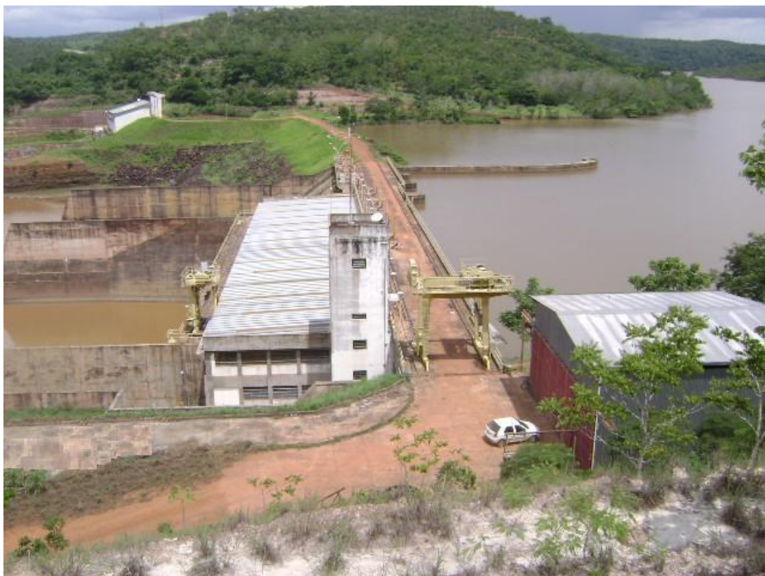
Fotografia 24 - UHE Isamu Ikeda implantada no rio Balsas (Foto: Enel Green Power, 2011).
