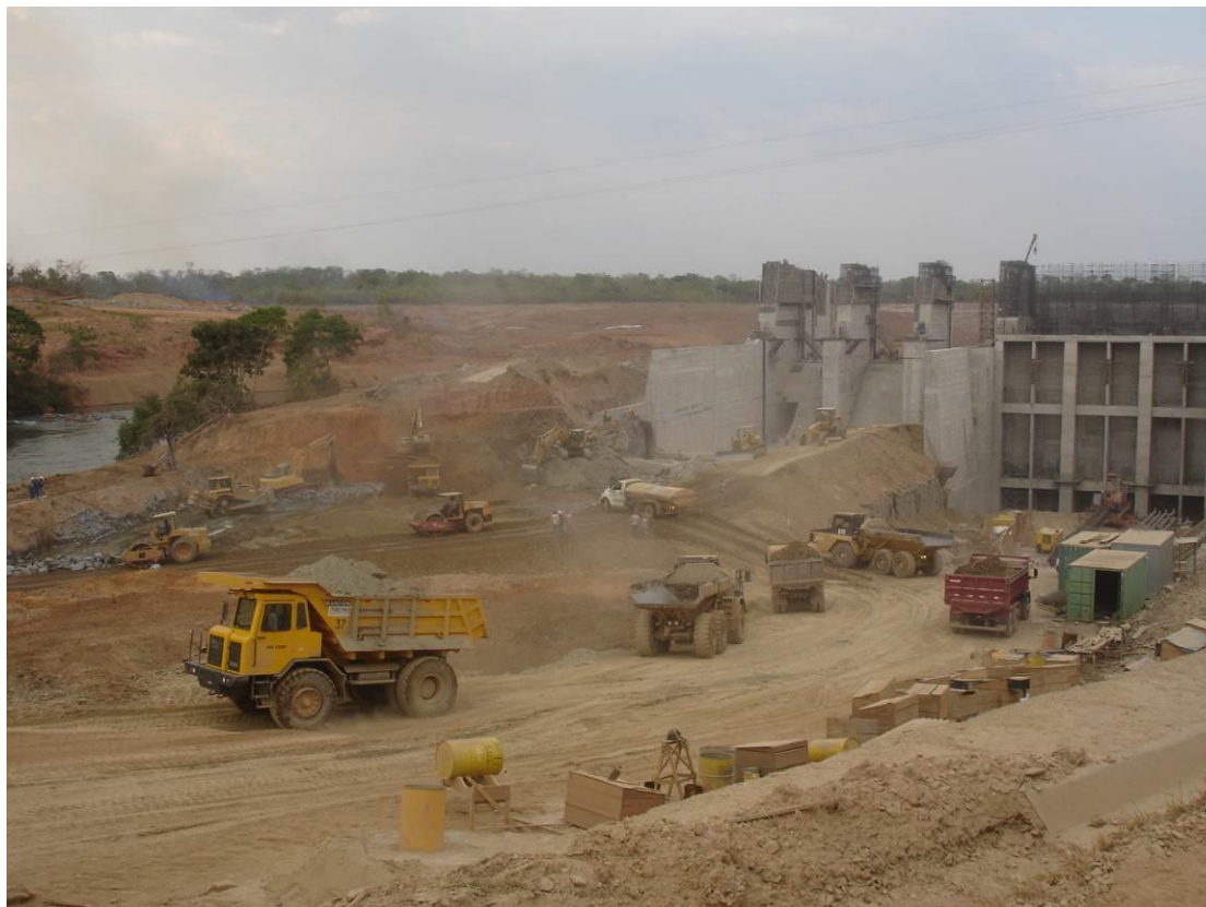
Fotografia 14 - PCH Lagoa Grande, canteiro de obras da PCH (Foto: Renan Gil, 2008).
