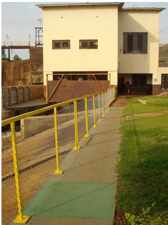
Fotografia 1 - CGH Corujão, casa de força e tomada d'água (Foto: Enel Green Power, 2011).
