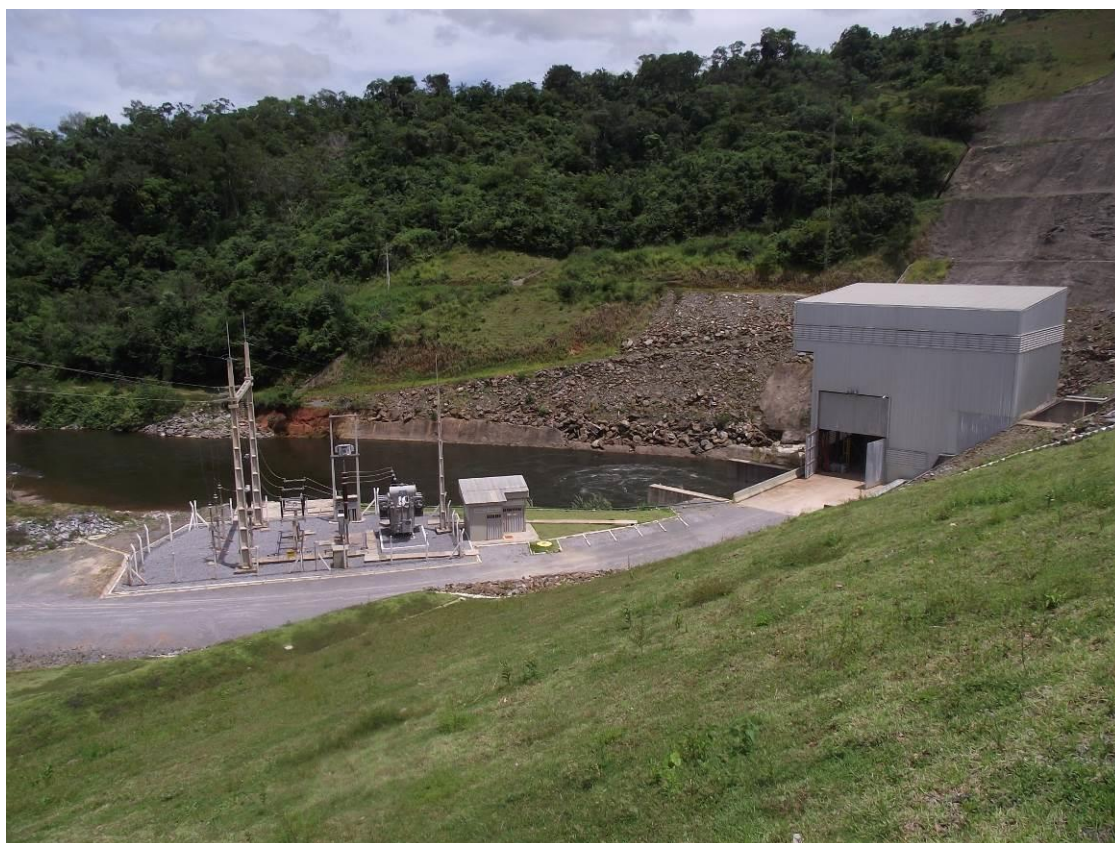
Fotografia 5 - PCH Areia, casa de força e sub-estação (Foto: Renan Gil, 2012).
