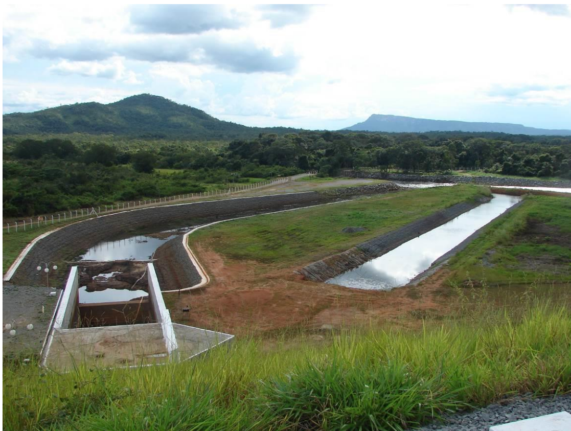
Fotografia 16 - Ponto de inserção da casa de força da PCH Manuel Alves (Foto: Renan Gil, 2008).
