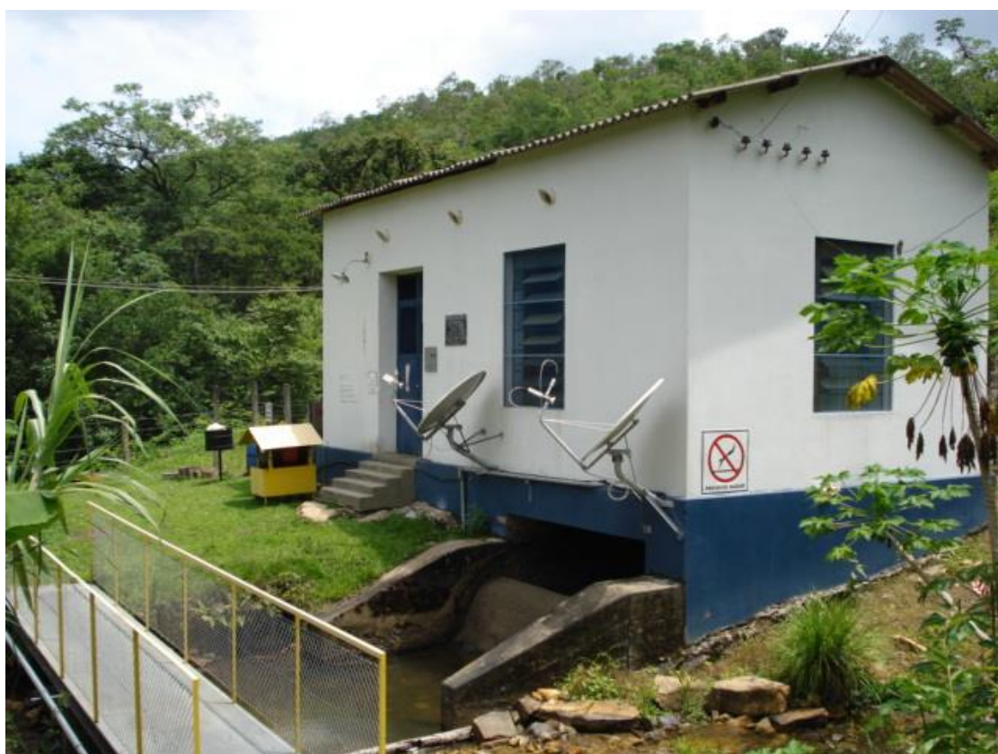
Fotografia 6 - CGH Bagagem, casa de força e tomada d'água (Fonte: Enel Green Power, 2011).
